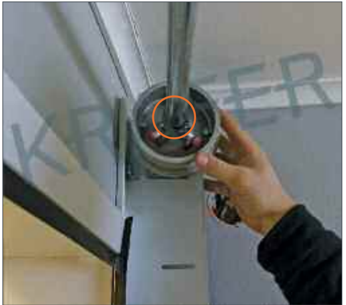
Visar höger wiretrumma med svart märkning. Montera axeln i lagerbockarna, skjut därefter wiretrumman in mot lagerbocken.
