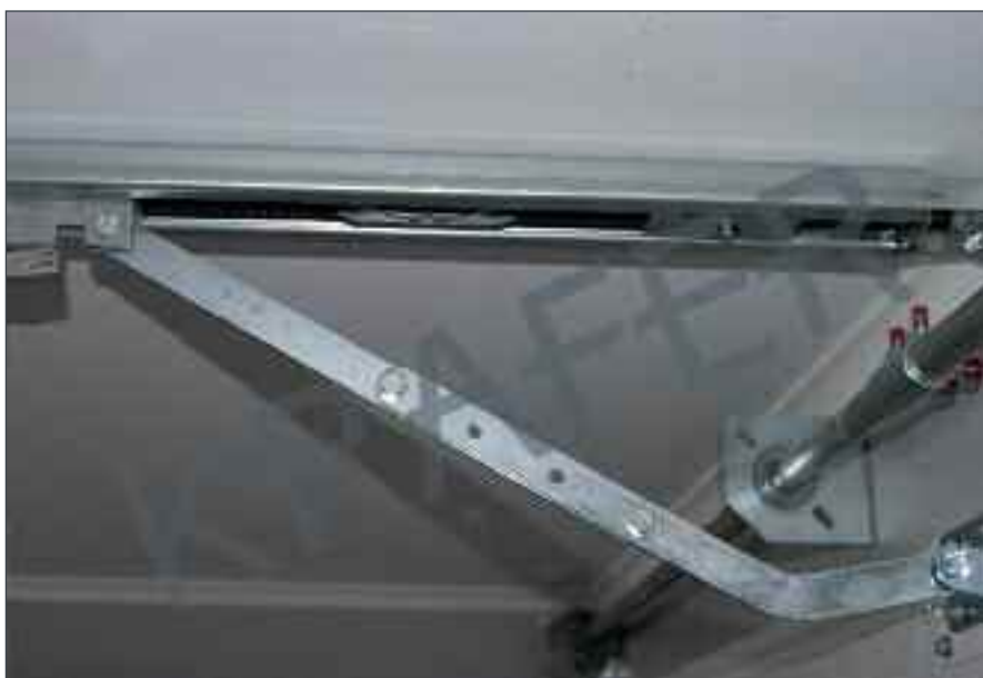
Visar dragarm vid överhöjd 20-40 cm. Skarvstycke måste användas.
